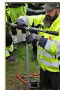
Fastdragning av bult
