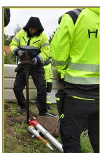
Demontering av insats från BP
