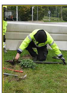
Mätning av gamla Ins. så att rätt längd erhålls
