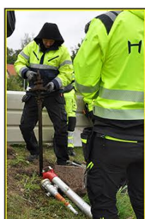
Demontering av insats från BP
