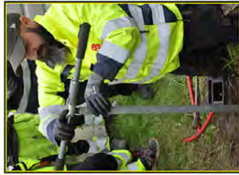
Fastdragning av bult
