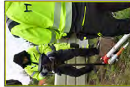
Demontering av insats från BP så att rätt längd erhålls
